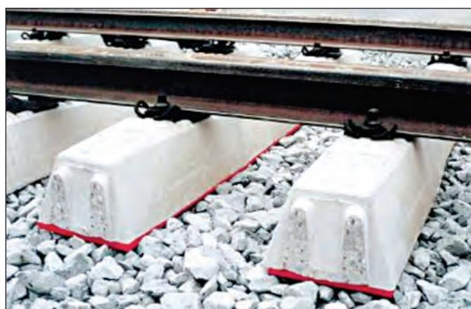
*Slika 4: Elastična podloška ispod betonskog praga na zastoru od tucnika*
