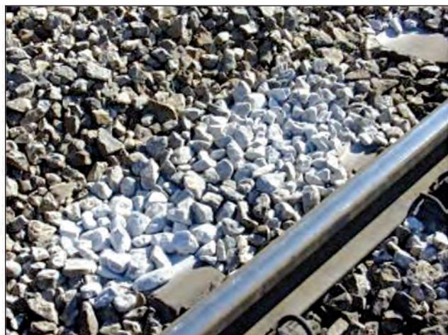
*Slika 3: Degradacija tucaničkog materijala na pruzi Škrljevo - Meja - Pećine*
