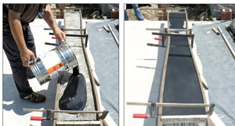
Slika 10: Ugradnja elastomerne mase
