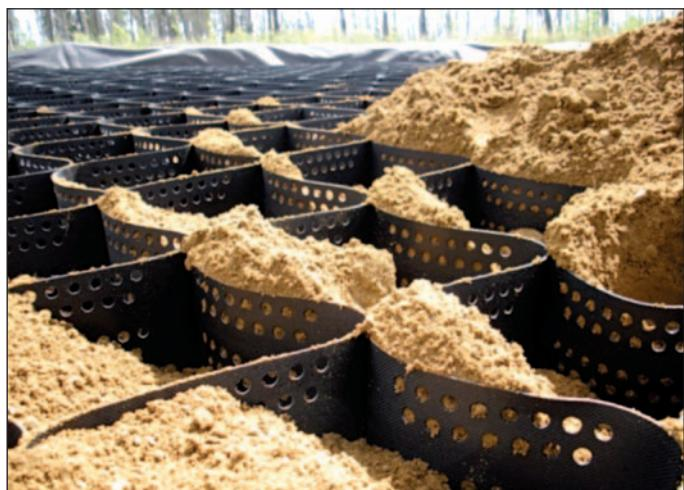
Slika 1: Prikaz geosaća u fazi izgradnje donjih slojeva nasipa
