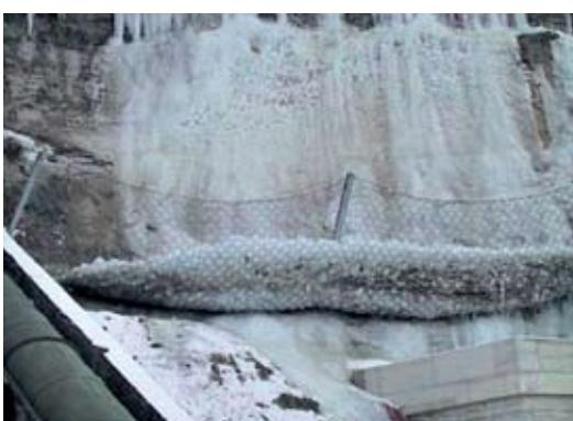
**Slika 8: Zaštita od odrona kamenja primjenom sustava za pasivnu zaštitu (GBE-barijere)**
