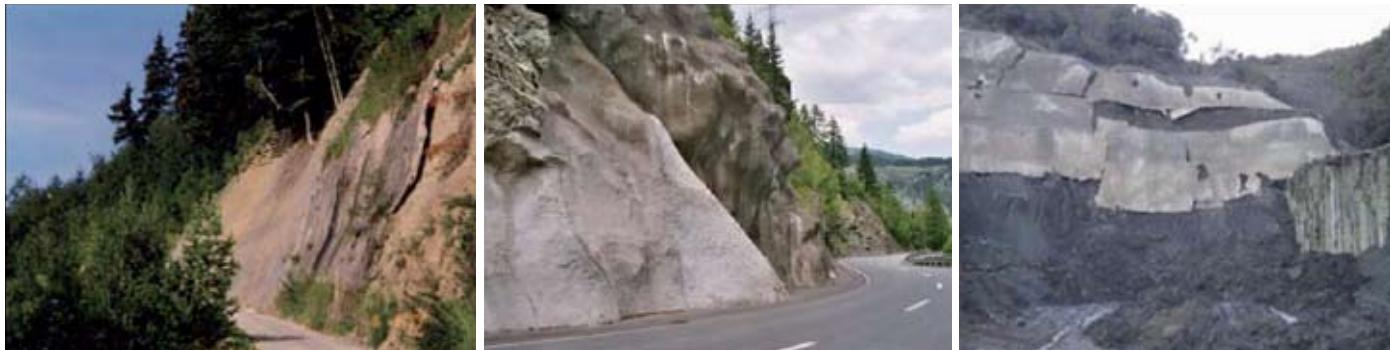
Slika 2: Zaštita od odrona primjenom mlaznog betona
