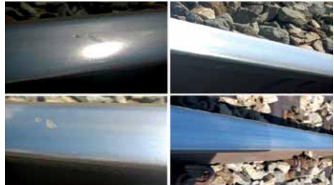
**Slika 10:** Primjer stanja tračnice prije i nakon korištenja vlaka koji je izveo glodanje 4. kolovoza 2015. na dionici između Moravica i Skrad (izvor: Vossloh)
