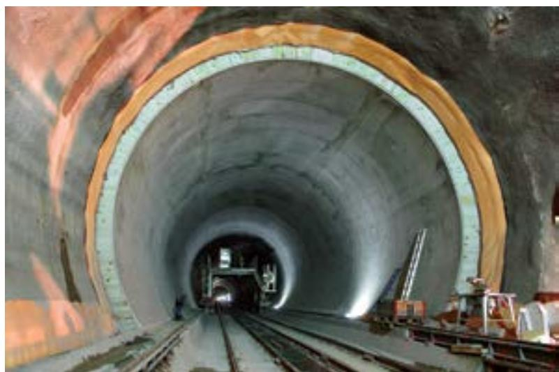
**Slika 1. Završno betoniranje baznog tunela Gotthard na lokaciji Amsteg 2007. godine (Foto: Alp Transit)**
