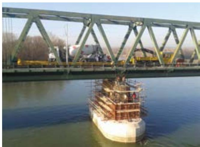
*Slika 3. Betoniranje prve kampade ojačanja stupa S3 izravno iz automiješalice dovezene na mjesto ugradnje na niskopodnom vagunu*
