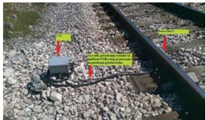
*Slika 2. Izvedeno stanje, izjednačavanje potencijala između vanjskih elementova uređaja SPA-2B/CR*
