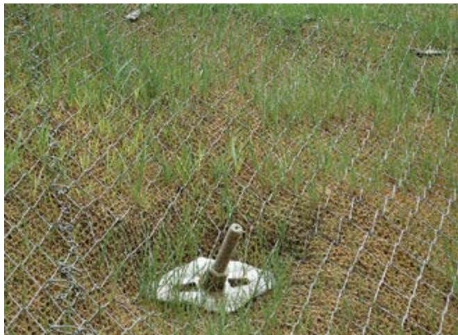
**Slika 10.** Geopletivo za kontrolu erozije TECMAT® u kombinaciji sa žičanom pletenom mrežom od čelika visoke čvrstoće TECCO® G65/3 na području s čavlanjem tla
