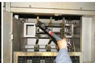
Slika 4. Pravilan način ispitivanja napona [2]
