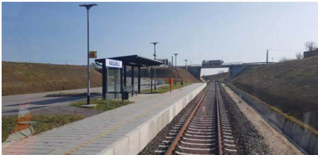
Jednokolosiječna, neelektrificirana željeznička pruga, predviđena za prigradski željeznički promet, duga je 12,2 km, a prilikom izrade projekta definirani su gabariti pružne dionice koja se u budućnosti može elektrificirati. Projektirana je za brzinu od 120 km/h (s izuzetkom prvoga luka iza željezničkoga stajališta Gradec koji je projektiran za brzinu od 100 km/h) te za osovinsku masu od 22,5 t i 8 t/m. Projekt vrijedan oko
