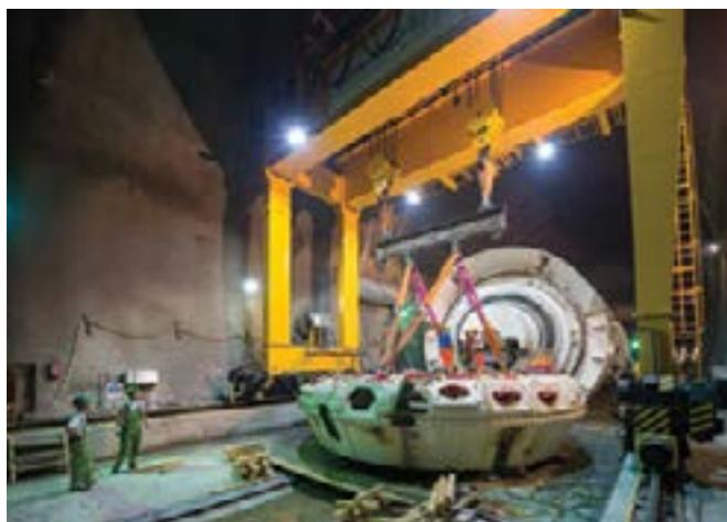
Slika 9: Montaža rezervne stroje TBM gradilišta Tulfes-Pfons na lokaciji Tulfes
