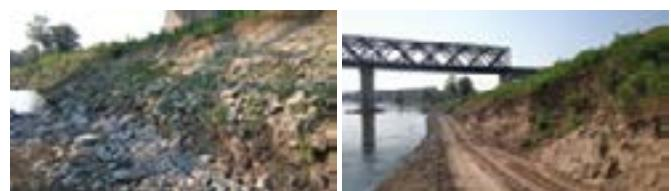
Slika 15. Urušena obaloutvrda (lijevo) u mostovskome profilu i nasip (desno) na lijevoj obali (pogled uzvodno).
