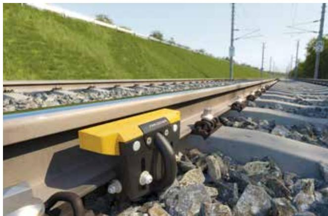
*Senzor RSR123 visokootporan na elektromagnetne smetnje*
