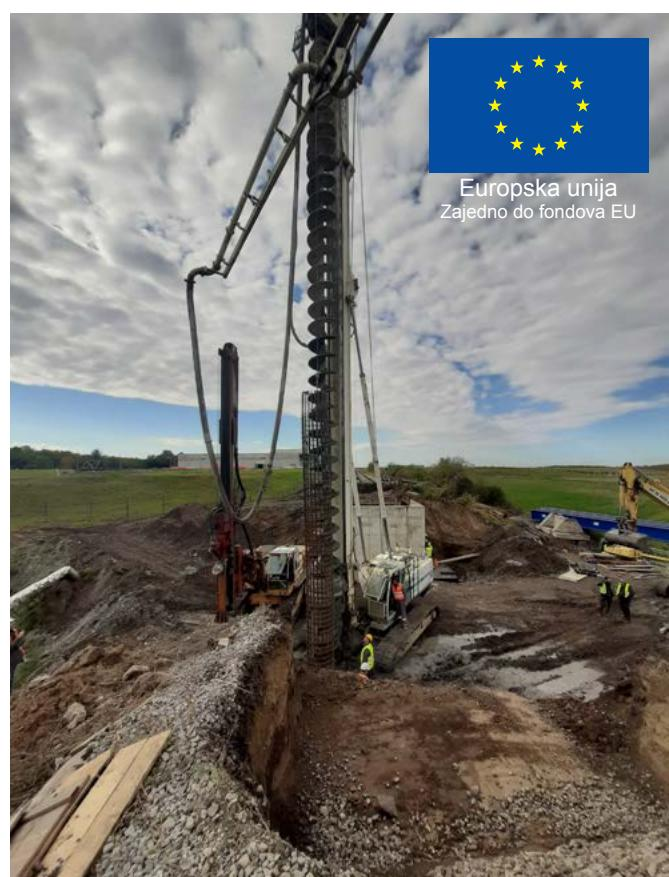
ski kanal. Izvode se armiranobetonski piloti za drugi upornjak mosta. U završnoj fazi radova na mostu, koja je planirana u prvome kvartalu 2021., uklonit će se provizorij i ugraditi nova mosna konstrukcija. – rekao je voditelj projekta.
