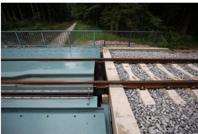
**Slika 14. Integrirani projekt nosača Corkelast® Embedded Rail System (sustav ugrađenih tračnica)**
