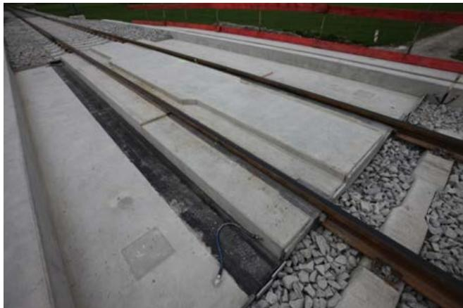
**Slika 12. Betonski mosta s integriranim kanalima za Crkelast® Embedded Rail System (sustav ugrađenih tračnica)**
