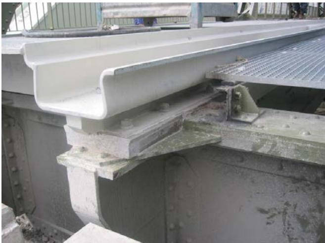
**Slika 13. Oblikovanje čeličnoga kanala za obnovu čeličnog mosta**
