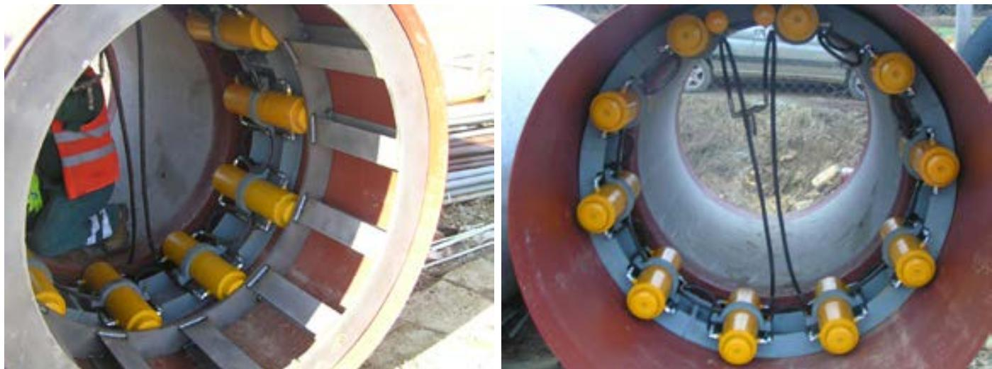
Slika 9. Prikaz međustanice i hidrauličnih cilindara
