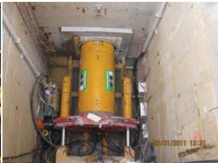
*Slika 3. Startna jama mikrotuneliranja*
