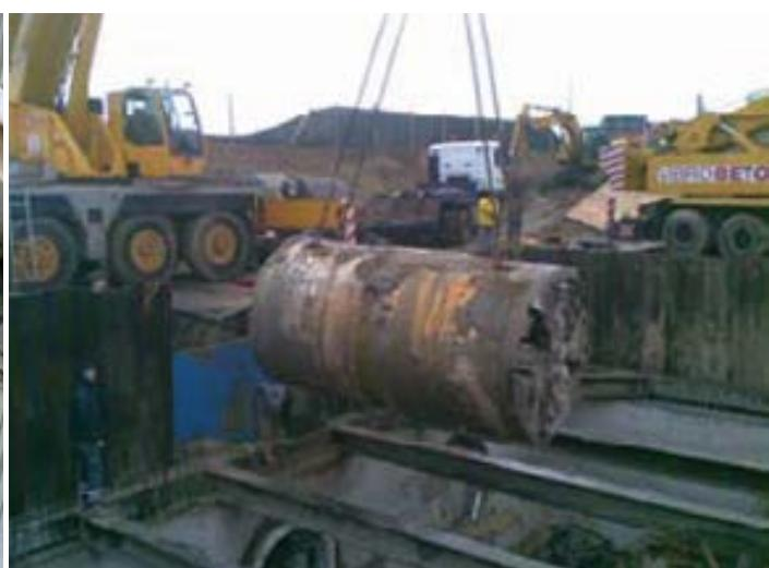
*Slika 4. Proboj tunela – bušenje stijenke zida izlaznoga okna / vađenje stroja za mikrotuneliranje*
