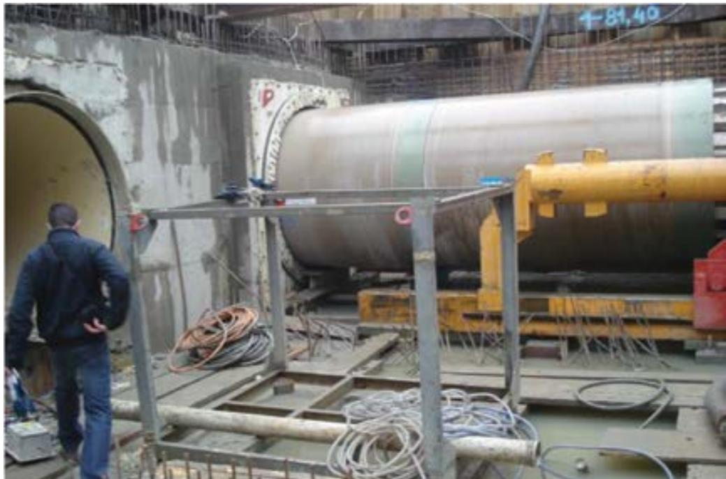
Slika 14. mikrotuneliranje - željeznički propust s ugrađenim poliesterskim cijevima
