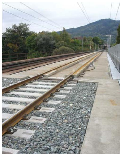
**Slika 10. Prijelazna konstrukcija, istočni upornjak (strana Brucka)**
