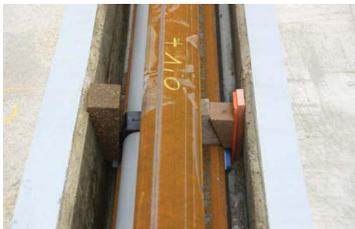
**Slika 9. Fiksiranje položaja tračnice u kanalu**
