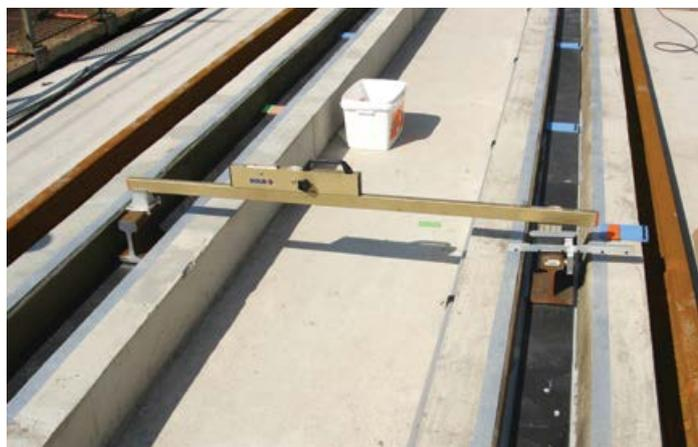
**Slika 8. Poravnanje vrha tračnice prema zahtijevanome položaju**
