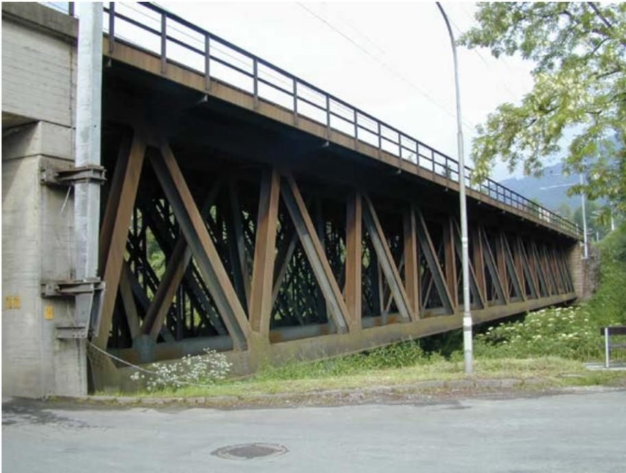
Slika 2. Čelično-rešetkasta konstrukcija mosta
