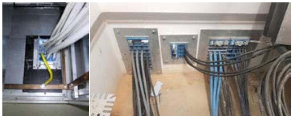
**Slika 1.** Primjena modularnoga sustava brtvlijenja
