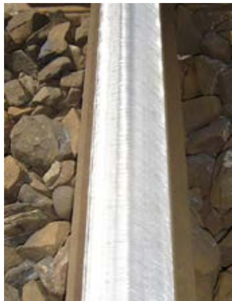
Slika 4. Tračnica nakon brušenja
