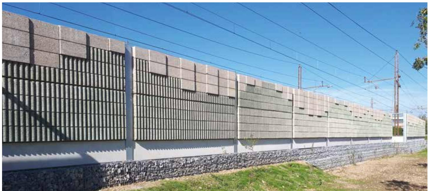
**Slika 2.** PHONOBLLOC® paneli za zaštitu od buke serije BHB (betonska nosiva jezgra i drvo-beton/drvo-cementni apsorberi). Naručitelj Ministarstvo infrastrukture RS, DRSI. Objekt - Zaštita od buke na dionici željezničke pruge Hoče – Rače kod Maribora
