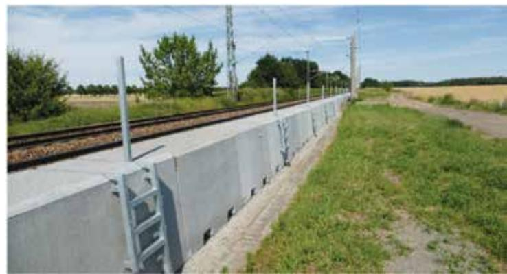
Slika 6. Quie@Rail zaštita od buke u blizini kolosijeka za željeznice
