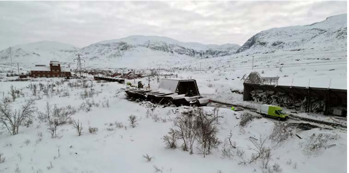
Slika 2. Radovi na popravku pruge nakon iskliznuća LKAB-ovog vlaka s rudačom u prosincu
