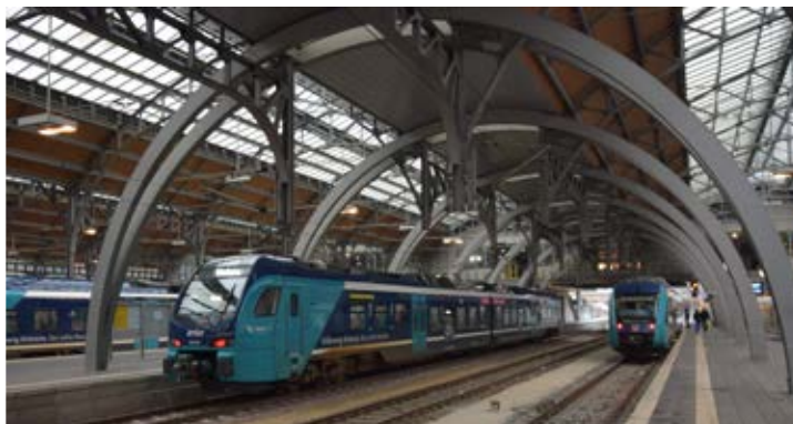
Slika 3. Kolodvor Lübeck Hbf; jasno vidljivi lukovi kojima je podignuta konstrukcija hale, sagrađeni su zbog elektrifikacije kolodvora
