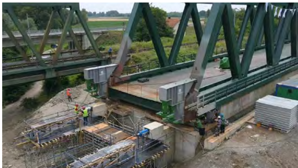
Slika 14. Šuplje dizalice, potezni blok i radni plato sa skelom
