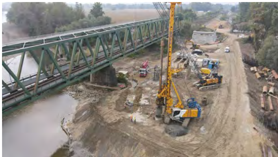
Slika 3. Privremeni nasip u koritu rijeke Drave i bušenje pilota za temelj stupa S1 [3]
