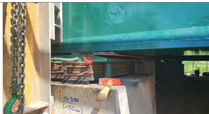
Slika 11. Primjer kliznog, teflonskog ležaja i čeličnih podložki
