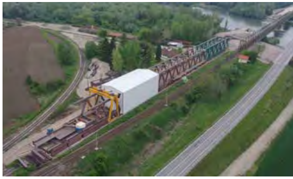
Slika 6. Sastavljanje dijelova konstrukcije na montažnome platou i pokretni zaštitni hangar [4]; privremene vertikale za reduciranje napona uslijed otklona pri potiskivanju
