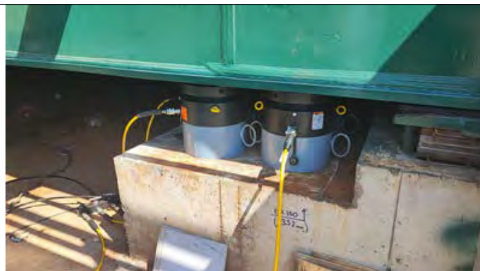
Slika 12. Bočne vodilice i hidraulične dizalice za podizanje mosta na platou
