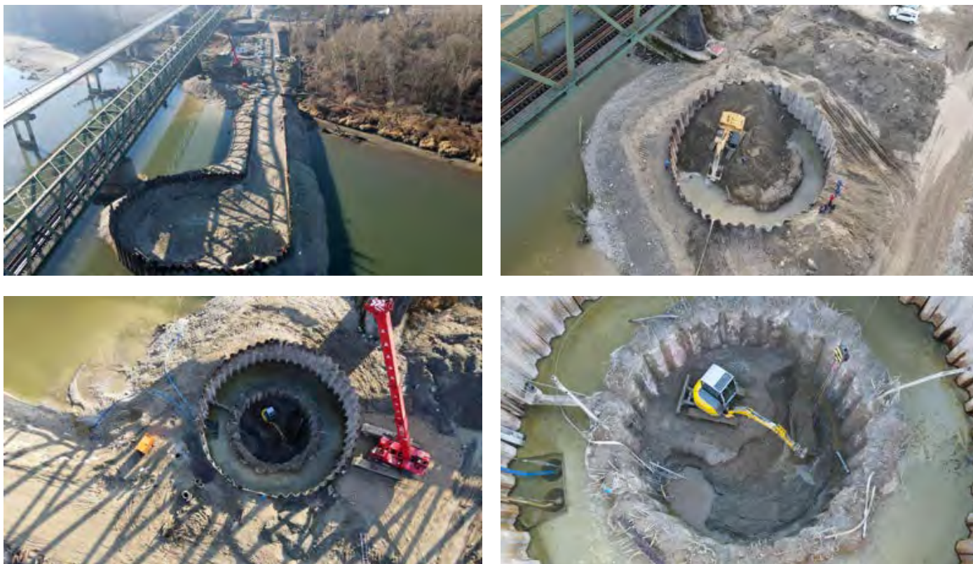
Slika 4. Čelične talpe i strojni iskop bunara za temeljenje stupova
