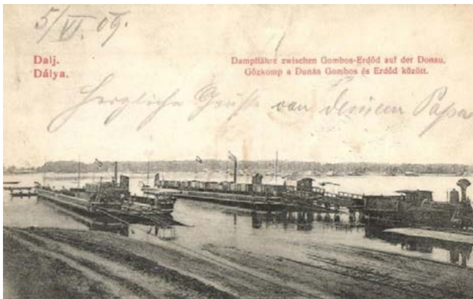
Slika 3. Razglednica s motivom ukrcaja vagona na skelu na desnoj obali Dunava
