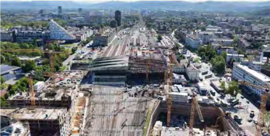
Slika 14. Izvođenje faze C – rekonstrukcija južnog dijela kolodvora uz aktivan promet sjevernim dijelom
