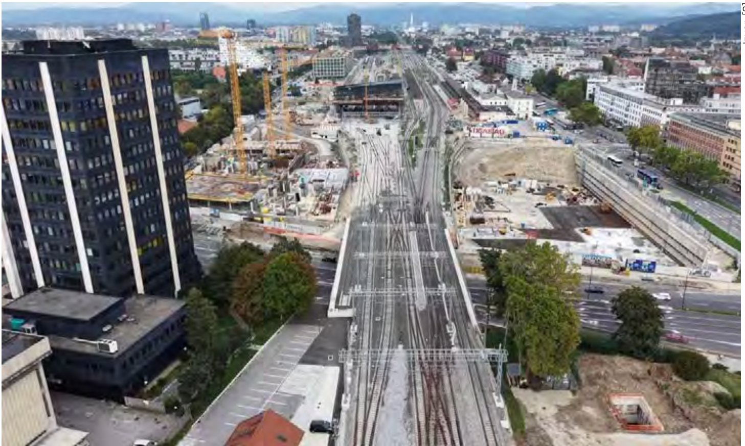
Slika 11. Novi nadvožnjak nad Dunajskom cestom sa šest kolosijeka – rezultat izvedene faze A
