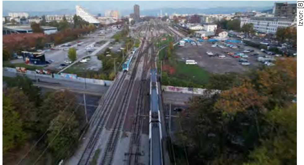
Slika 3. Postojeće stanje kolodvora prije rekonstrukcije iz smjera Ljubljane Zalog – pogled na stari nadvožnjak nad Dunajskom cestom – četiri kolosijeka
