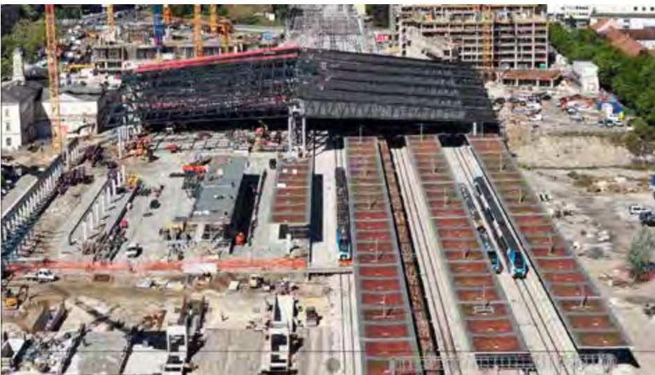
Slika 15. Trenutačno stanje kolodvora tijekom izvođenja faze C
