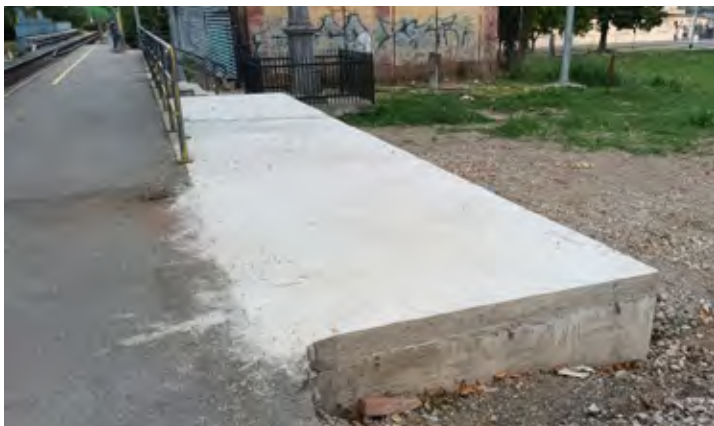
Slika 5. Stajalište Osijek Dravski Most – AB ploča na betonskim temeljima prije ugradnje nadstrešnice
