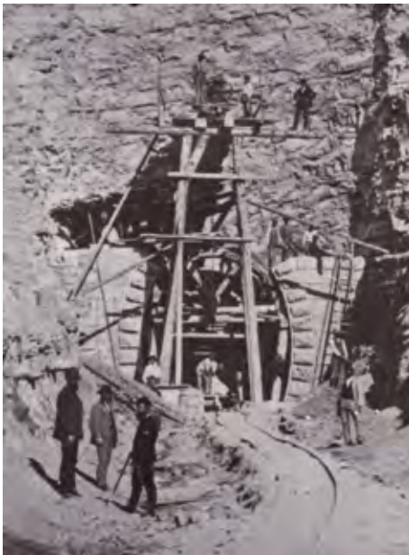
Slika 6. P Radovi na tunelu kod Boruta tijekom izgradnje pruge
